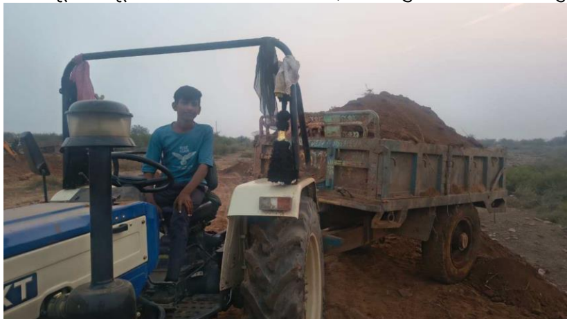
चित्र 7.18: सोनी गांव में पोखर निर्माण कार्य प्रगति पर
